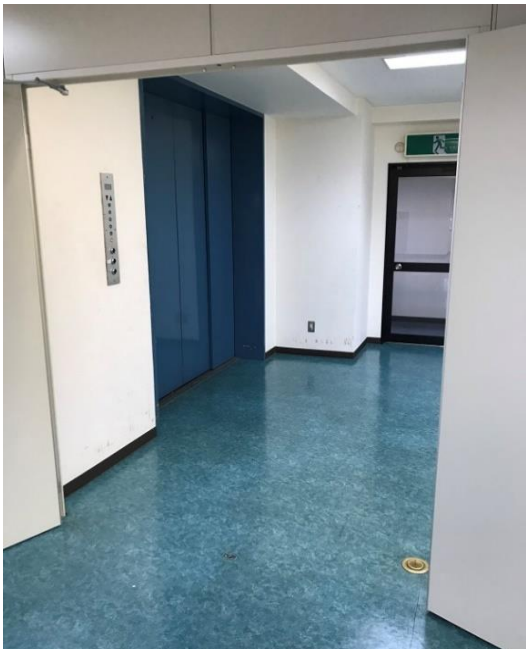
【 貨物用エレベーター 】
